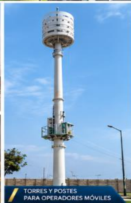
INSTALACIÓN Y PUESTA EN SERVICIO
