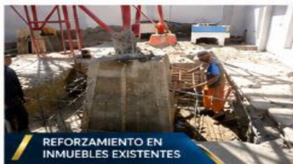
REFORZAMIENTO DE ZAPATAS Y CIMENTACIONES
