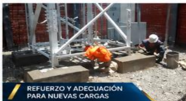
REFORZAMIENTO DE COLUMNAS Y BASES DE TORRE
