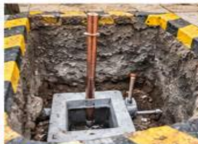
SISTEMAS DE PUESTA A TIERRA Instalación y medición (megado)
