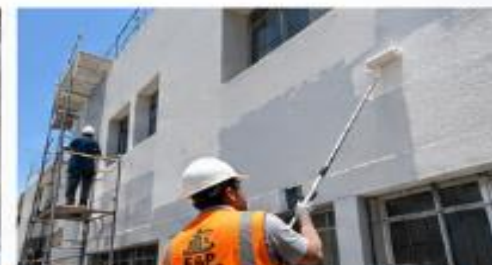
PINTURA INTERIOR Y EXTERIOR
